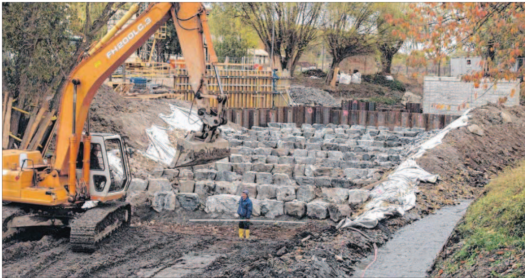
Wahre Felsbrocken wurden für die Sohlgleite auf den Ilse-Grund gelegt. Links und rechts erheben sich im Hintergrund die Widerlager, auf die bald die neue Fußgängerbrücke gesetzt wird. Das Wasser des Flusses wird während der Arbeiten an der Baustelle vorbei geleitet. Fotos (3): Mario Heinicke
