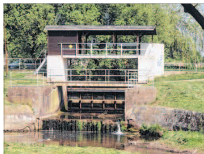
Die Wehranlage „Großes Schütt“ ist Geschichte. Sie wurde zum Beginn der Bauarbeiten abgerissen.
