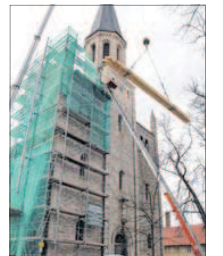
Frisches Holz wird zum Einbau hochgezogen. Foto: Horst Müller
