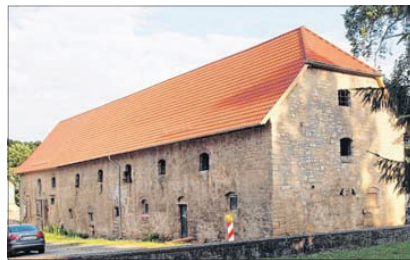
In diesem alten Stallgebäude soll der Dorfladen entstehen. Das Dach ist gerade erneuert worden. Fotos (2): Mario Heinicke
